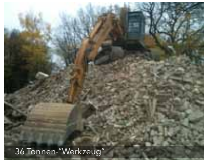
Abschluss der Abrissarbeiten am späten Nachmittag
